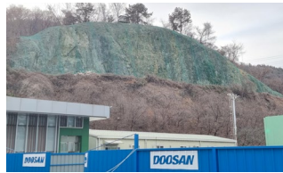
암절개지 낙석방지 시설물 설치
