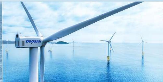
두산에너지빌리티는 국책과제를 통해 10MW급 풍력발전기의 설계, 조립, 설치 및 실증 전반을 담당하고 있으며, 부품 신뢰성 시험과 자동화 장비 개발을 진행하고 있습니다. 해당 모델은 국내 저풍속 환경에 맞춰 설계되었으며, 평균 풍속 6.5m/s에서도 이용률 30% 이상으로의 발전이 가능한 로터 직경 205m의 풍력 터빈입니다. 이를 통해 10MW급 해상풍력 분야에서 경쟁력을 확보할 예정입니다.
